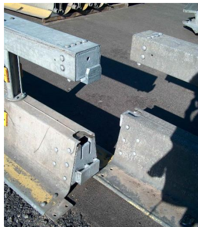
spoj rychlého rozebrání (quick joint) pro použití u Varioguardu
