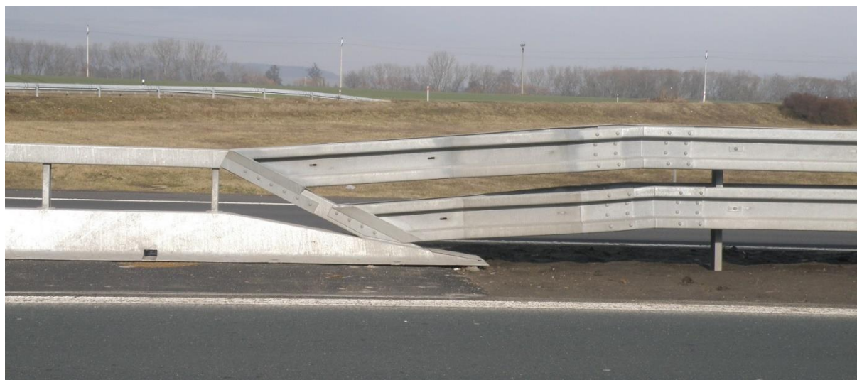
Obrázek 11 - Foto přímého napojení Varioguardu na oboustranné ocelové svodidlo OSNH4/H3
