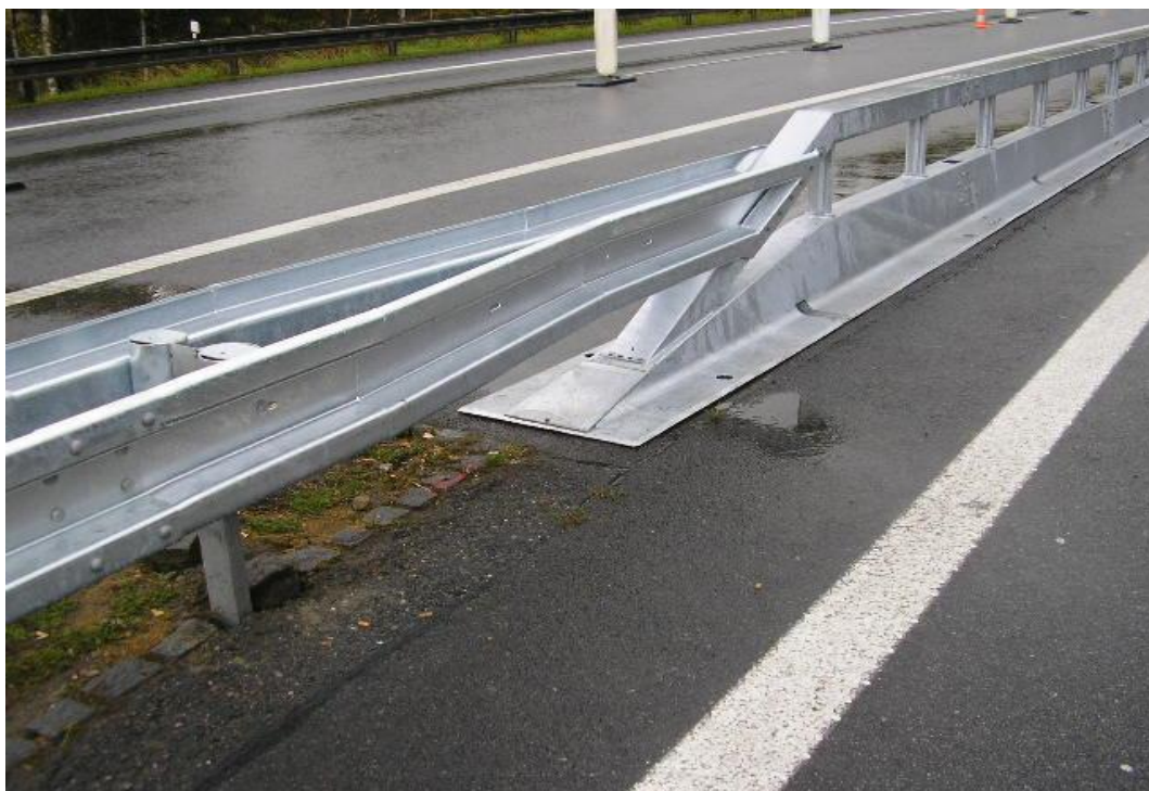
Obrázek 10 - Foto přímého napojení Varioguardu na oboustranné ocelové svodidlo NHKG
